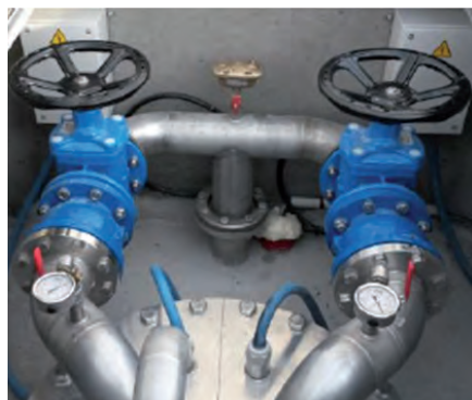
Principe de la tête de puits future
